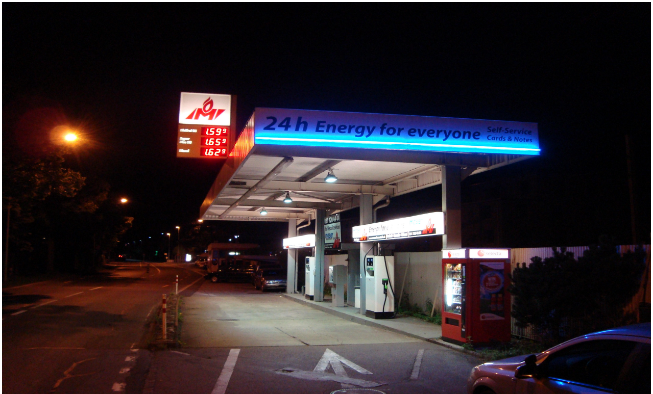
UDL AP Installation an einer unbedienten Tankstelle (mit Automat)
