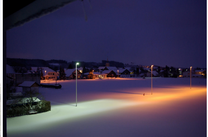
USL2, 56W (weiss) im Vergleich mit HQI 120W
