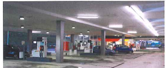
UNITRON LED-Tubes und LED-Strahler für Tankstelle, Waschplatz, Verbindungsstrasse, Waschstrasse und Shop.
